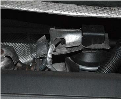
Dommages par rongeurs
